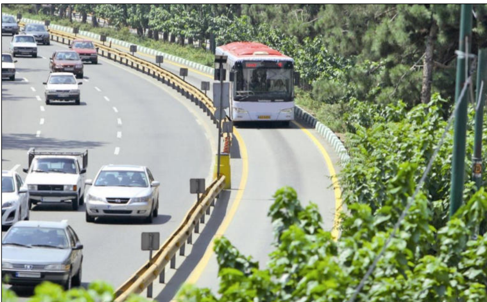
شکل ۳-۷- نمونه خط ویژه اتوبوس جدا شده با موانع فیزیکی در تندرگاه شهری
