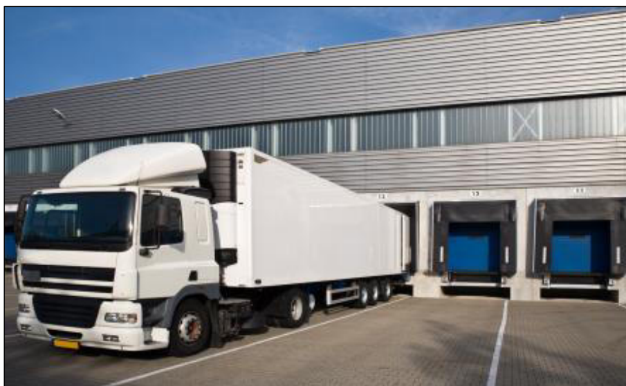
شکل ۳-۶- فضای بارگیری و باراندازی دارای سایه‌بان و هم راستا با دیوار بیرونی ساختمان
