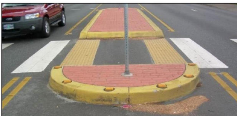
شکل ۱۶-۳- نمونه‌های اجرا شده از جزیره‌های ایمنی بدون شیب‌راه برای عبور عابران پیاده
