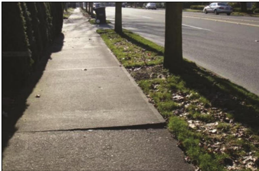
شکل ۱۰-۲- نمونه‌ای از عدم پیوستگی در روسازی پیاده‌رو
