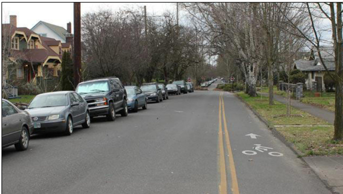
شکل ۸-۲- نمونه خط‌کشی مسیرهای دوچرخه خلاف جهت
