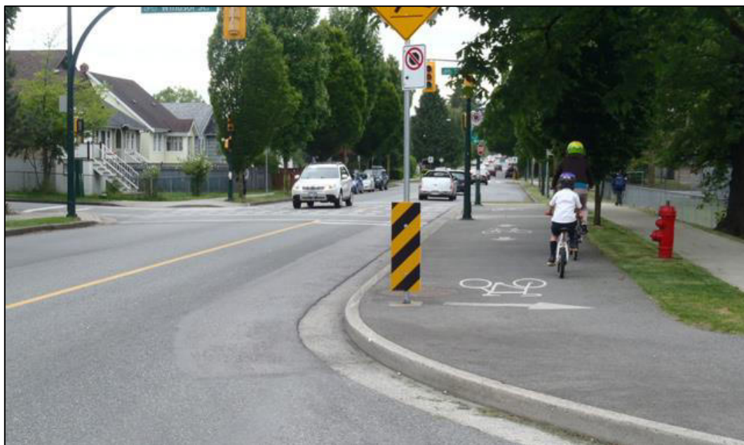
شکل ۴-۲- جداسازی مسیر درجه ۱ از سواره‌رو با استفاده از ایجاد اختلاف ارتفاع
