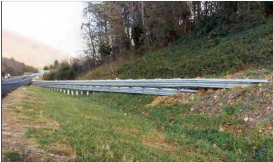
شکل ۵-۱۹- نمونه‌ای از مهار کردن ابتدای حفاظ در شیروانی
