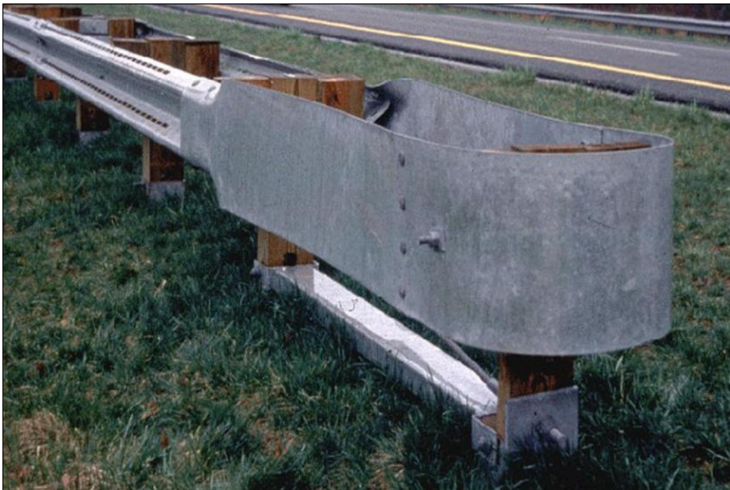
شکل ۶-۲- ضربه‌گیر ابتدایی مستهلک کننده
