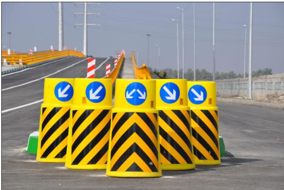
شکل ۶-۷- استفاده از بشکه‌های ماسه به عنوان ضربه‌گیر
