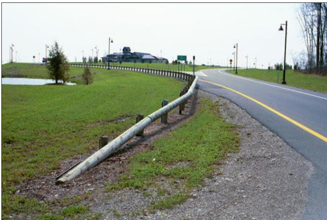
شکل ۵-۱۸- نمونه‌ای از بالی شکل کردن و فرو بردن ابتدای حفاظ در زمین
