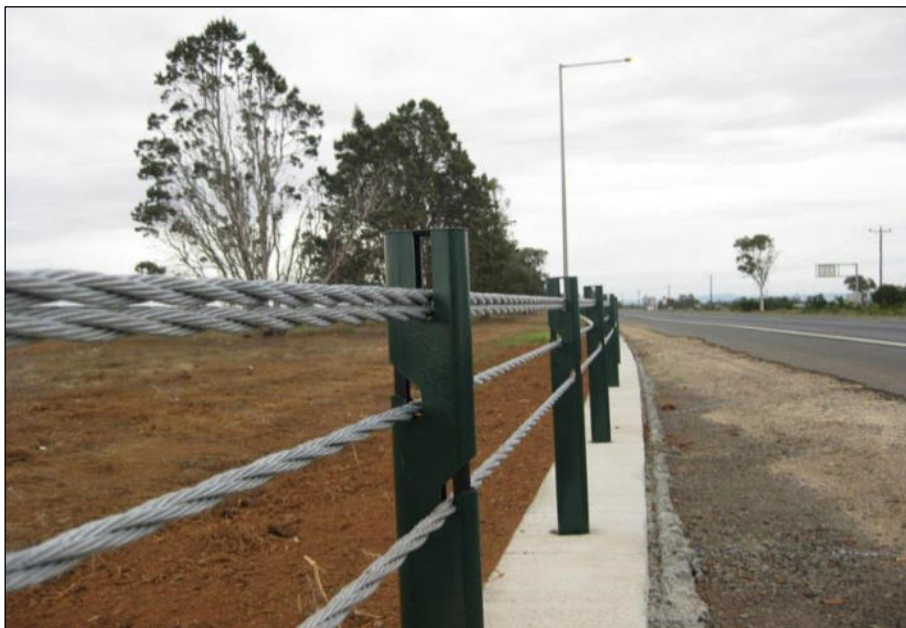
شکل ۲-۳- نمونه‌ای از حفاظ‌های فلزی کابلی
