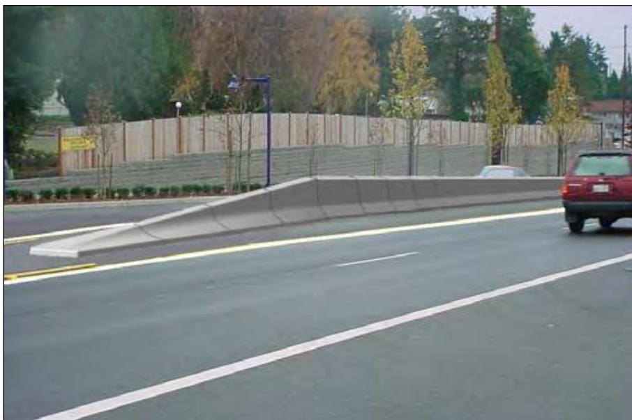
شکل ۵-۲۰- نمونه‌ای از شیب‌دار کردن ابتدای حفاظ بتنی
